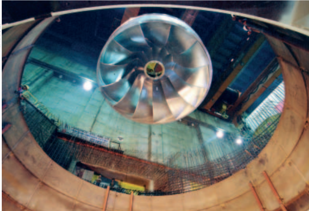
Plaatsing van turbine 18A, de tiende aan Braziliaanse kant.
