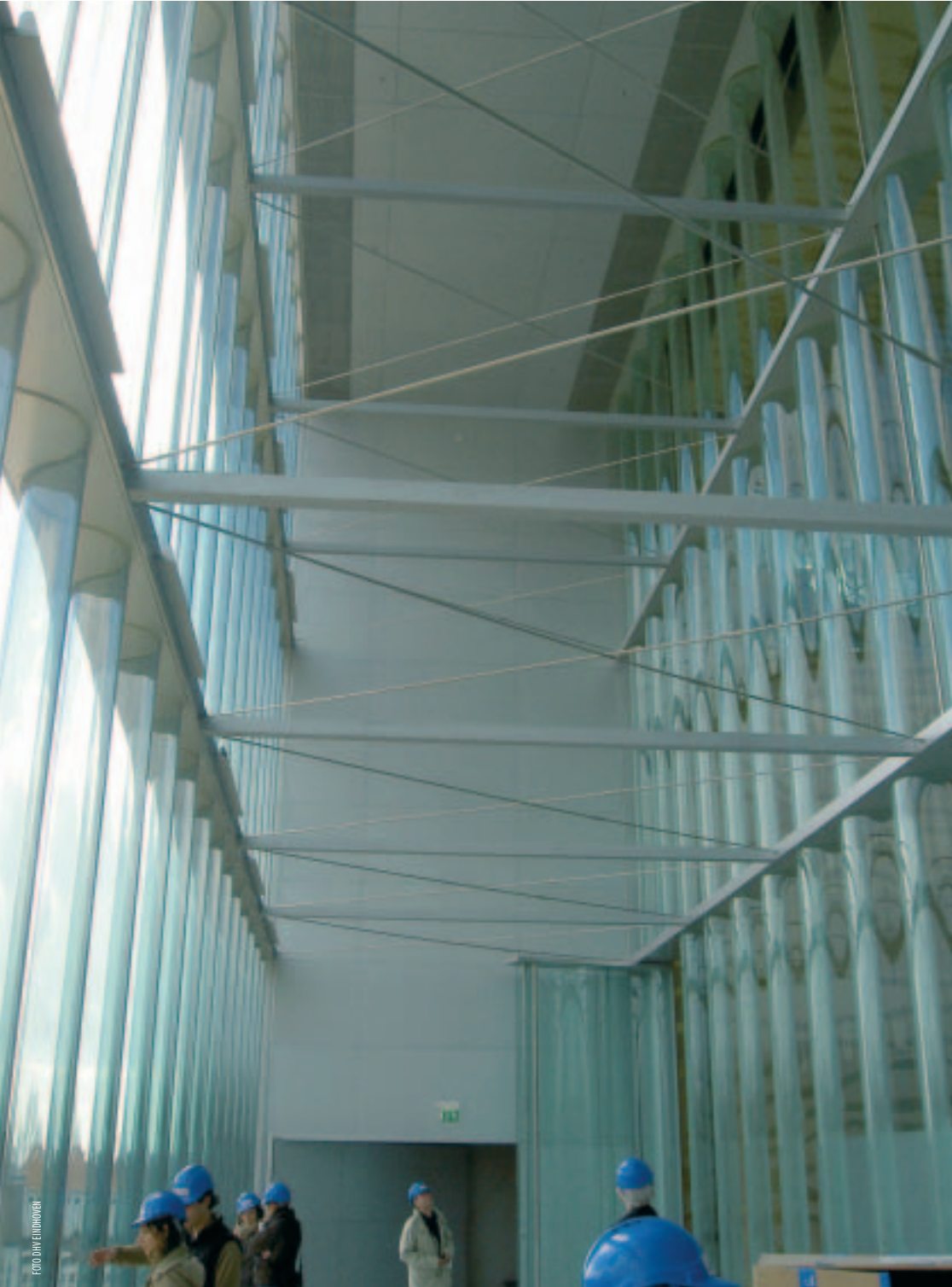
De foyer tussen de binnenramen en de buitenramen vormt een bufferzone voor het verkeerslawaaï.
